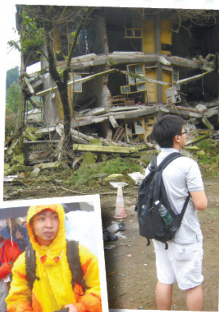
原是六層的樓房，地震後已陷入地底
